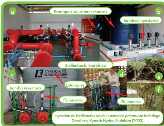
**Figura 118.** Inyección de fertilizantes solubles materias primas a través del fertiriego en la localidad de Stellenbosch, Sudáfrica (a, b, c, d, e y f) (Gentileza de Kynoch Hydro, 2003).
