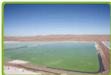
Figura 81. Pozas de concentración de sales con energía solar (Fuente: Gentileza, Departamento de Marketing, SQM , 2007).
